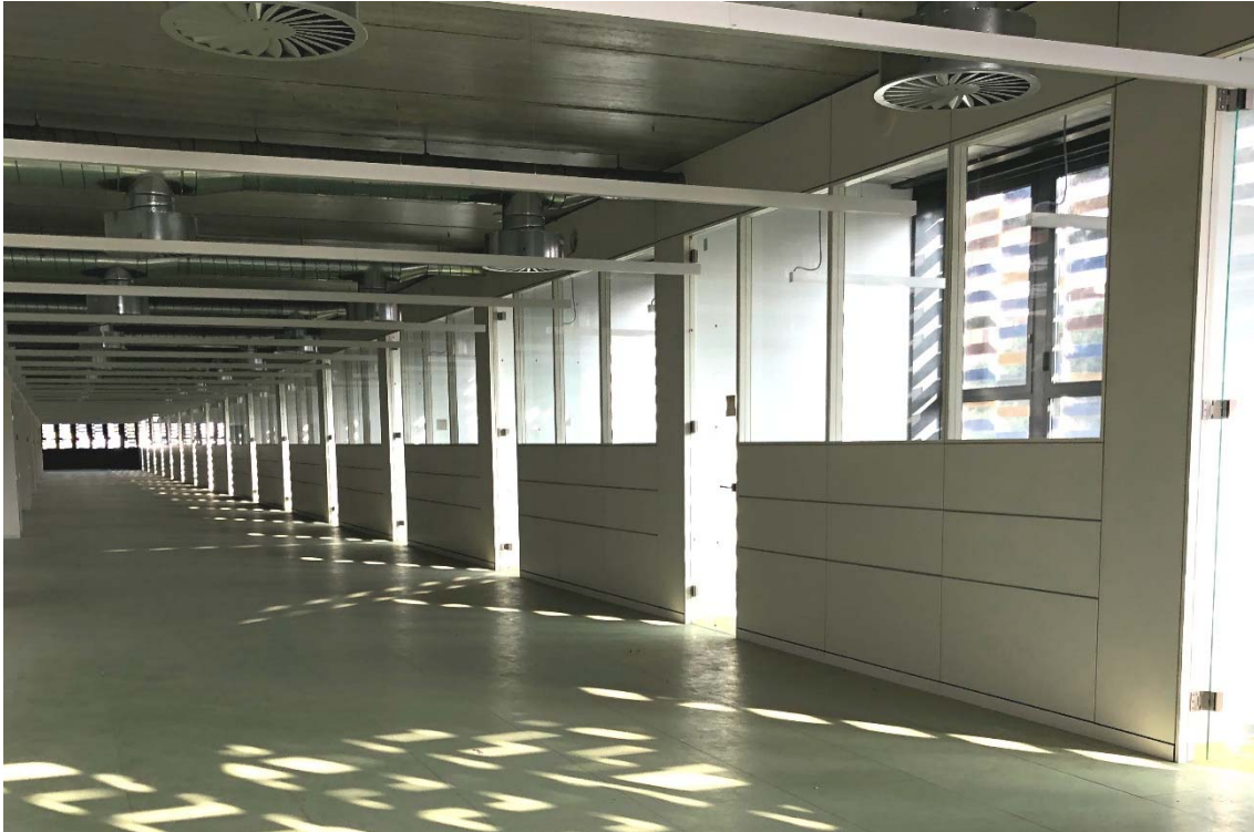
Interior. Imatge: PICHarchitects_Pich-Aguilera
