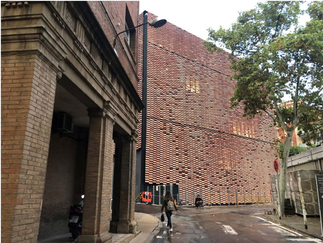
Façana al recinte de St Pau. Imatge: PICHarchitects_Pich-Aguilera
