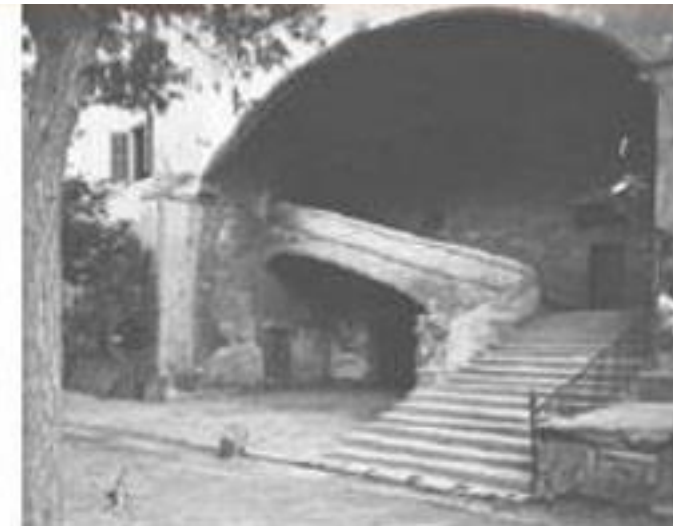
Escalera de hombres
